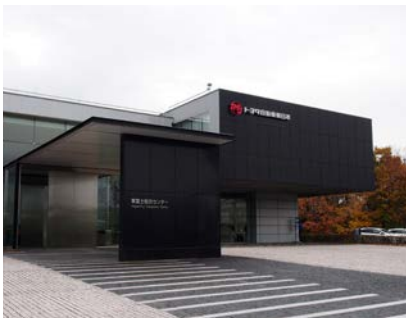
トヨタ自動車東日本株式会社 東富士総合センター
